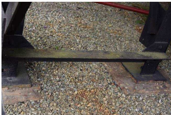
Il. 3 i 4. Korozja elementów konstrukcji wieży nośnej wiertnicy, Bóbrka 2016
