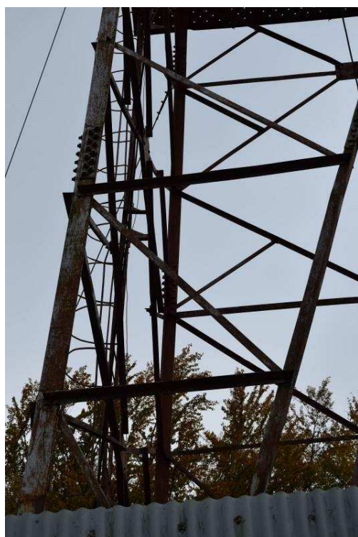
Il. 3, 4. Korozja elementów konstrukcji wieży nośnej, Bóbrka 2016
