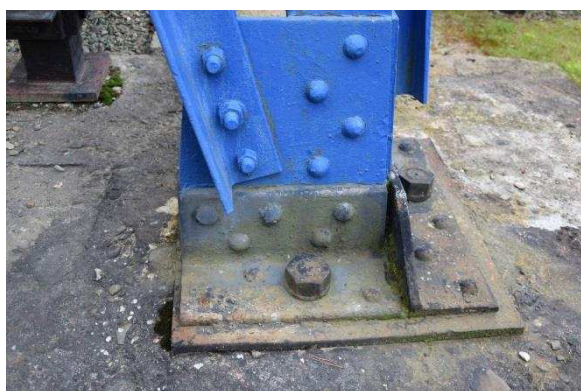
Il. 3 i 4. Korozja elementów konstrukcji wieży nośnej wiertnicy, Bóbrka 2016
