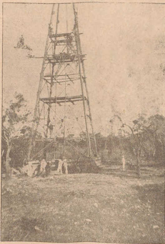
Montowanie wieży żelaznej.
