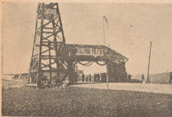
Brama tryumfalna w kształcie wieży wiertniczej przed kopalnią Rogi.
