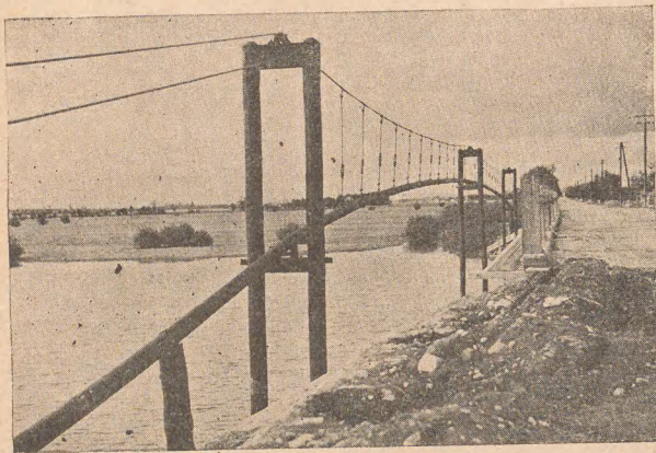
Widok mostu linowego dla gazociągu obok Rozwadowa.
