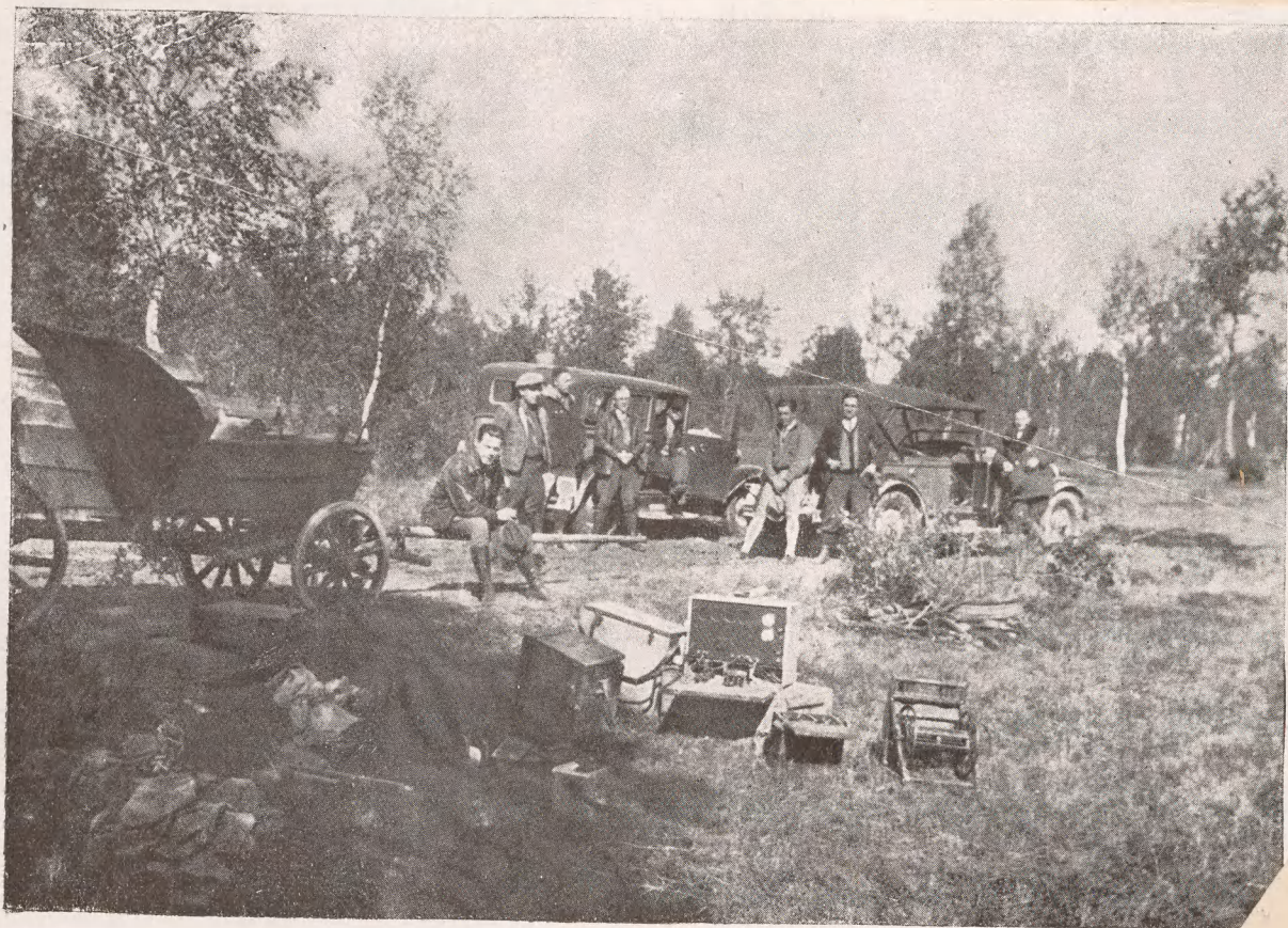
Grupa geosejsmiczna przy stacji nadawczej.
