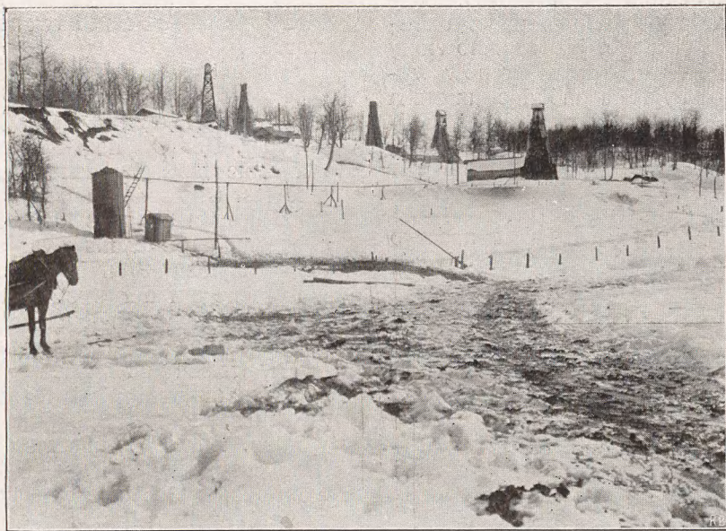
Widoki kopalń w Majkopie. — Ansichten der Gruben in Maikop.
